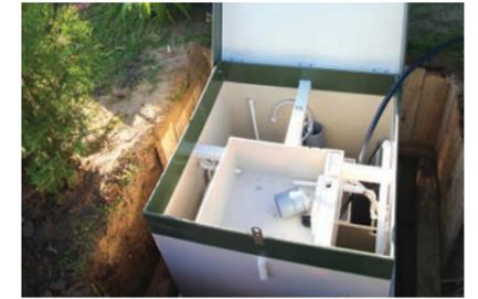
Одновременная, по 0,5 м, обсыпка песком снаружи УОСВ и заливка водой внутри. Это делается для компенсации внешнего и внутреннего давления на стенки установки.
