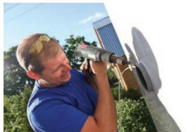
Герметичная врезка подводящей трубы в приемную камеру.
