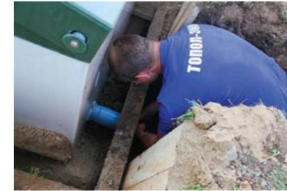
Врезка в приемную камеру непосредственно по месту подведения канализационной трубы. Подсоединение проложенных труб.
