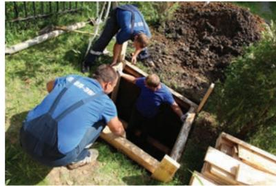
Для опалубки используется прочный брус 100x100 и доски 150x40 длиной 3-6 м, в зависимости от размера котлована. По окончании монтажа опалубку можно либо засыпать, либо снять и оставить Заказчику.
